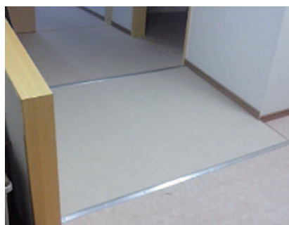
改修してスロープが完成
