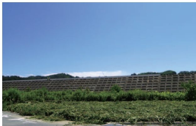
昭和の大津波後に作られた防潮堤(提供: NPO田老)
